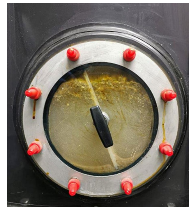
Prüffenster Fettabscheider
